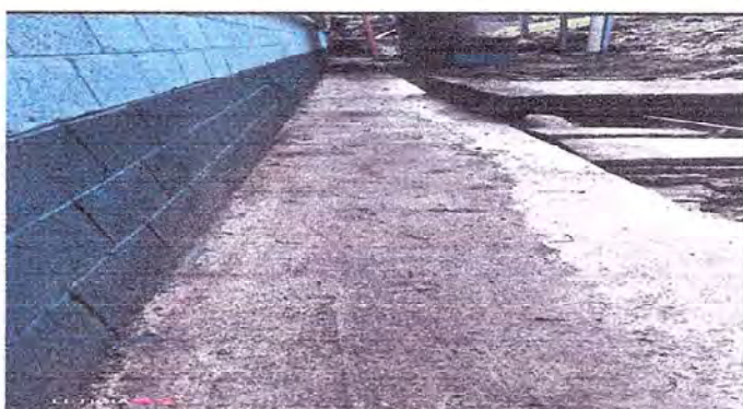
foto 4. losa de patio reparada.
