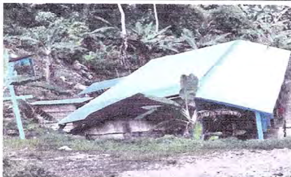
foto 1. Lámina instalada.
